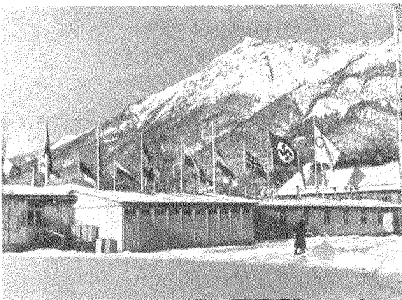
Olympic Transmitter Hut at Garmisch-Partenkirchen.
